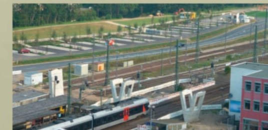
Nicht nur der Lennepark, auch der von Land und Bahn gebaute barrierefreie Übergang und Zugang zu den Bahngleisen nähert sich der Fertigstellung
